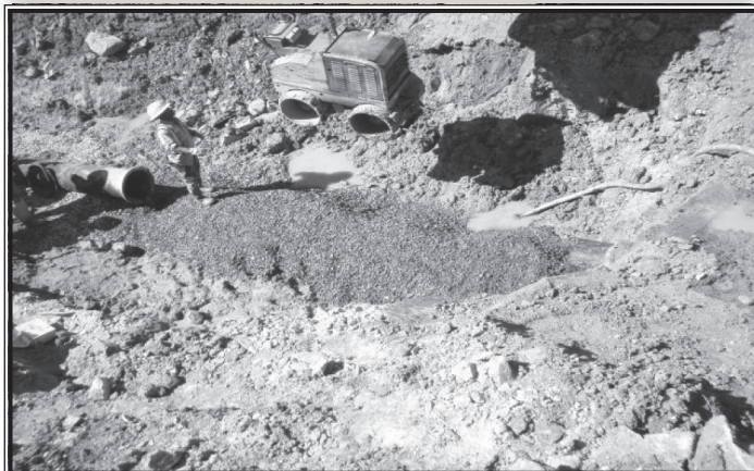
Los empleados municipales reparan las roturas de tuberías de agua potable
